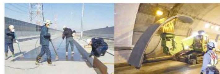
コンクリート床版防水施工
